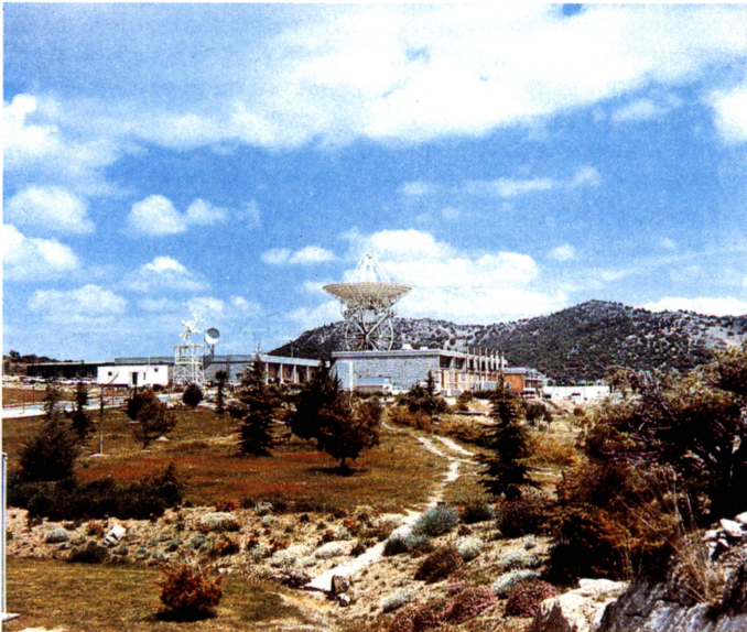
Las parábolas para la recepción directa de señales procedentes de satélites cercanos son de pequeño tamaño, pero no sucede así cuando se han de recoger señales muy débiles procedentes de satélites lejanos.
