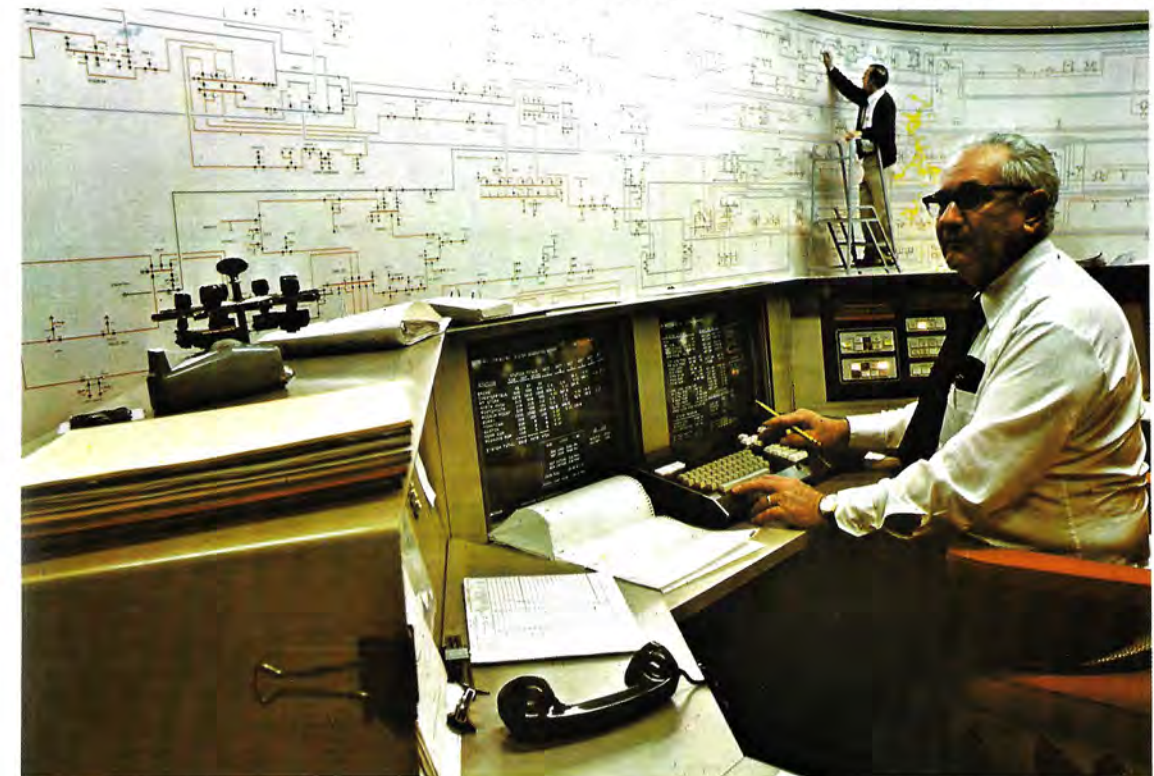
Cuadro de control de una central eléctrica de distribución.
