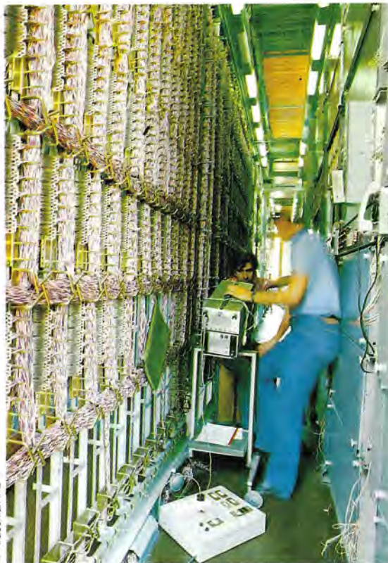
Un momento de los trabajos de conexión y verificación de los enlaces exteriores.
