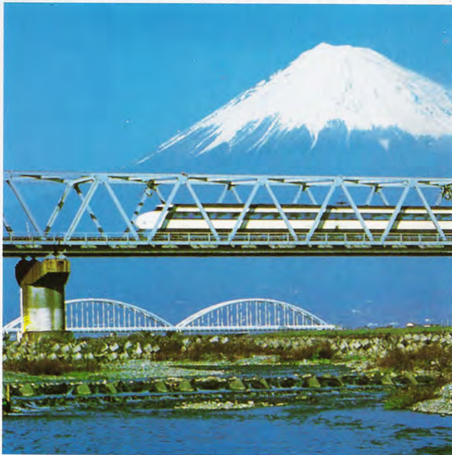
De nada sirve la elevada velocidad de los modernos ferrocarriles si no se dispone de los correspondientes y adecuados sistemas de supervisión y coordinación del tráfico.
