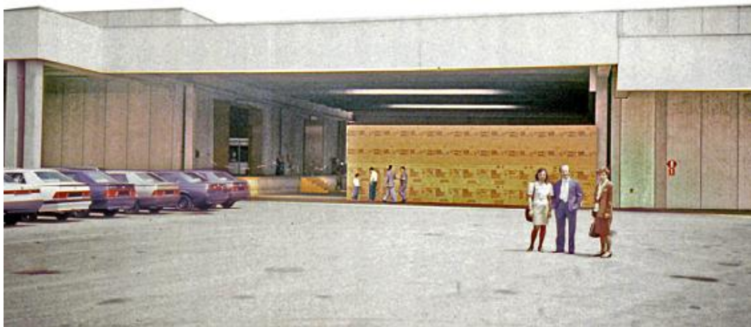
Pavia - Altra visuale dei due magazzini Cariplo
