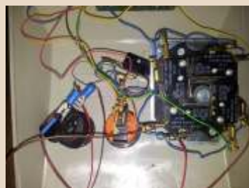
Después, con el microswitch desmontado y el nuevo montado.
