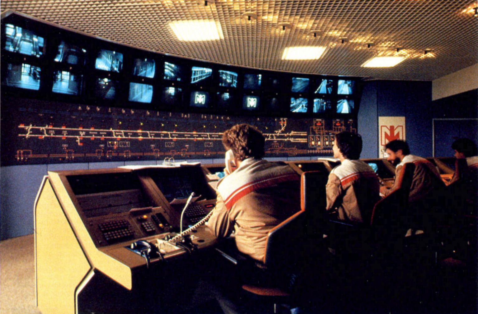
Le symbole du nouveau visage du Nord : le VAL. Construit par Matra et conçu par le professeur Gabillard de l'université scientifique et technique de Lille, un passionné de voile, ce métro piloté par ordinateur est entièrement automatique. Un poste central de contrôle la commande. Il transporte 57 000 voyageurs chaque jour.
