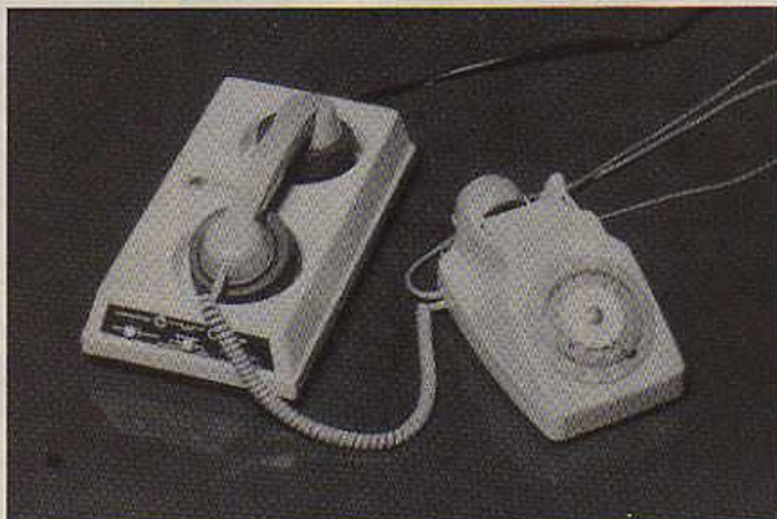
Liaison téléphonique entre ordinateurs (Modem Anderson-Jacobson).
