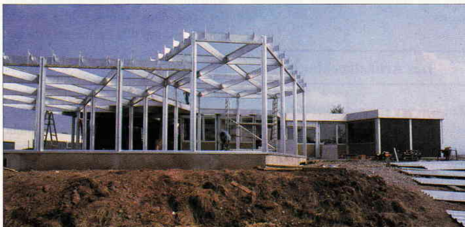
Schwierige Arbeitsbedingungen in der Bauphase: Der Anbau im Vordergrund
